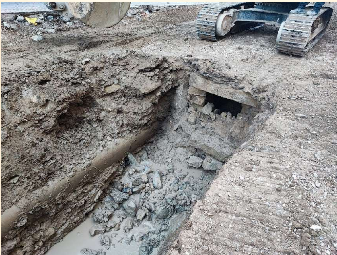
Arqueología preventiva. Control de los movimientos de tierra
